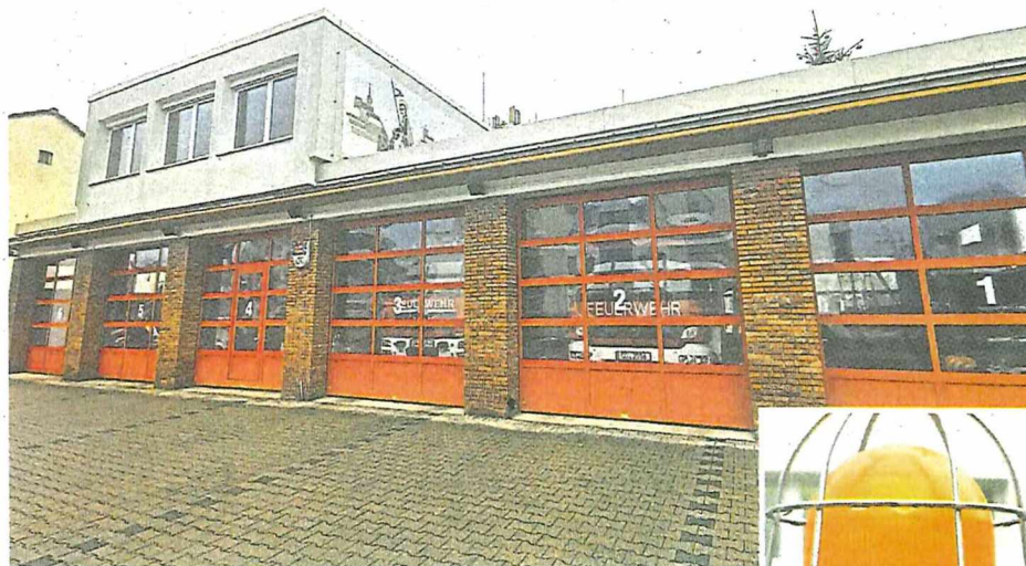
Leuchtsignale sind unter anderem am Feuerwehrgerätehaus zu finden.
